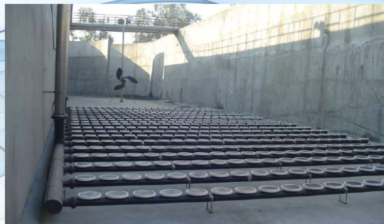
Diffuser Installation with Mixer Instalación de difusor con mezclador
