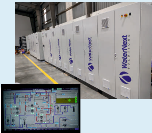
DAF system for flow 4800 mcd in Mexico Sistema DAF para flujo 4800 mcd en México
