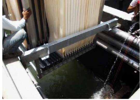
MBR Installaton Instalación de MBR
