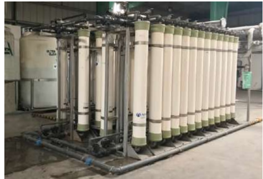
Ultra Filtration for flow 2500 mcd in India Ultrafiltración para flujo 2500 mcd en India
