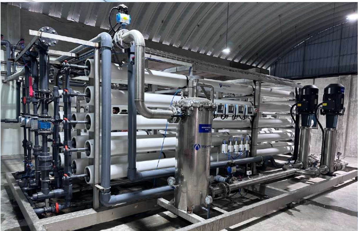
Reverse Osmosis plant for flow 1500 mcd in India Planta de Ósmosis Inversa para caudal 1500 mcd en India
