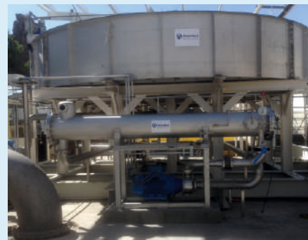
DAF system for flow 4800 mcd in Mexico Sistema DAF para flujo 4800 mcd en México
