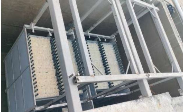
MBR Installaton instalación de MBR
